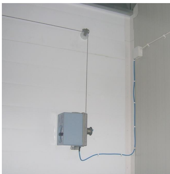
Spjeldmotor montert på vegg med wirehjul over.
