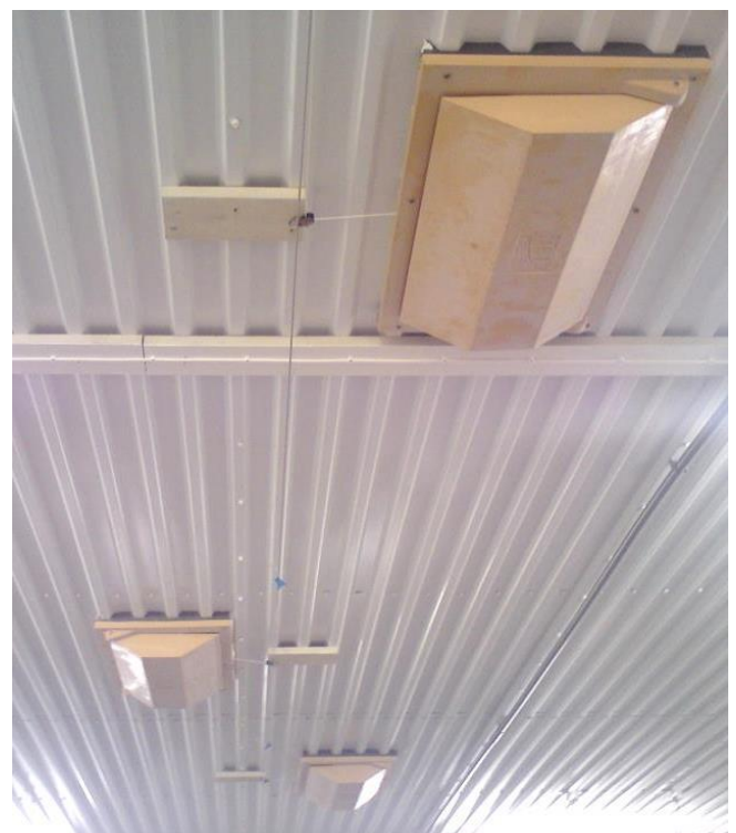
Loftsventiler midt etter rommet med wiretrekk i mellom.
