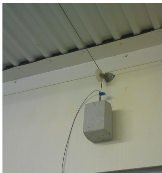
Returlodd montert på vegg med wirehjul over.
