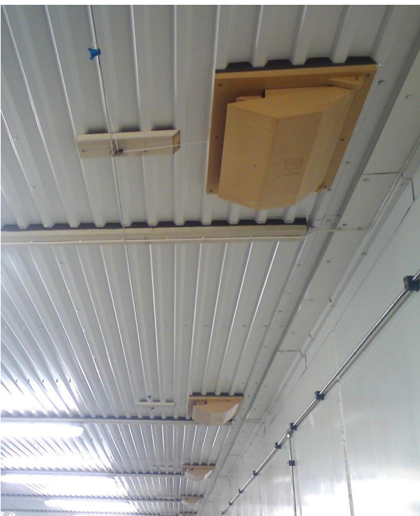
Loftsventiler langs yttervegg med wiretrekk i forkant.
